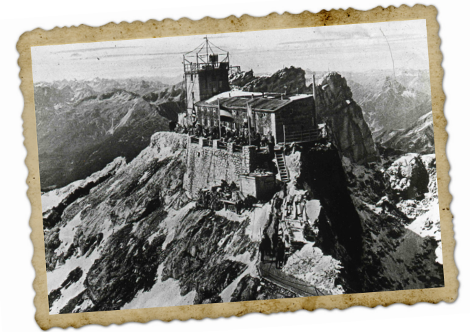
Wetterstation Zugspitze, historisches Münchner Haus (Bild: DWD)
